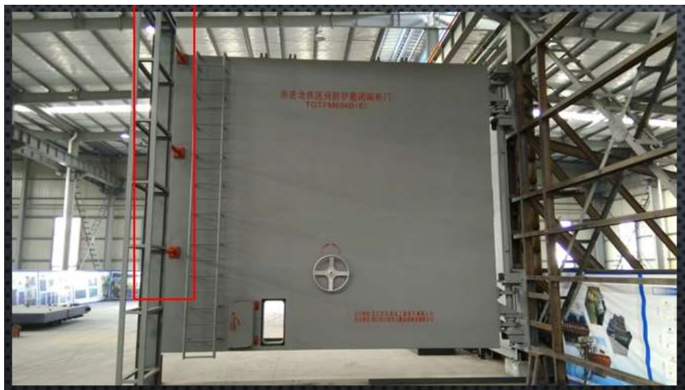
第四套安全措施，刚性水平拉杆固定装置
